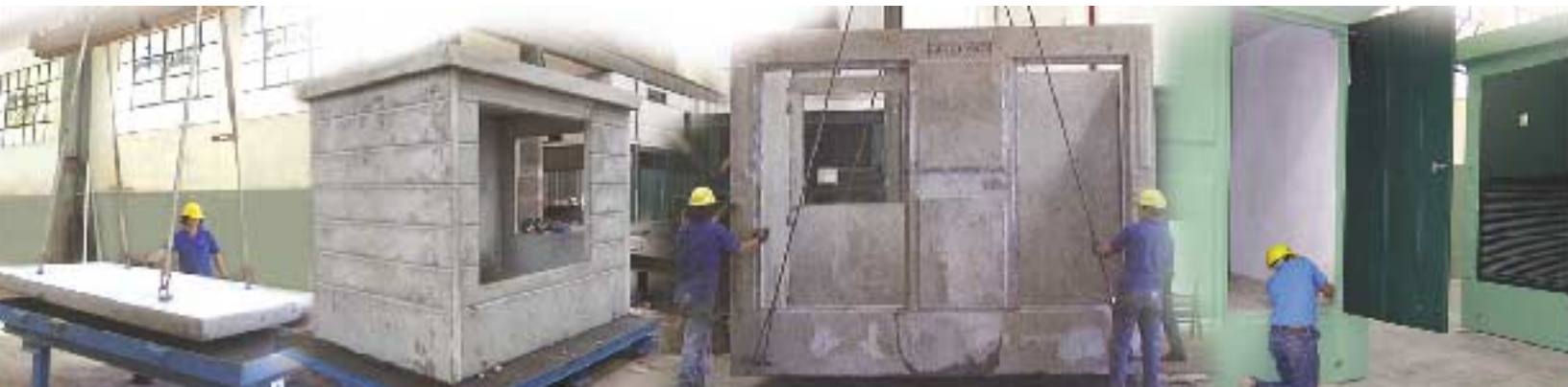
➤ Ejecución de los primeros edificios
