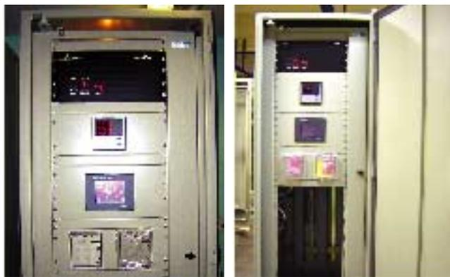
*Figuras 4 y 5 > Vista de la puerta abatible interna con todos los elementos montados en ella. De arriba hacia abajo: D25, Recdigit, Quick Panel™ y relés de protección.*
