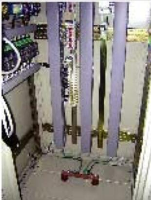
Otros aspectos constructivos se pueden ver en la *figura 3* donde se muestra un parcial del interior del tablero en el que se ven entre otros, las borneras previstas para la interfase con el exterior de forma de facilitar el cableado en obra y la barra de puesta a tierra.
