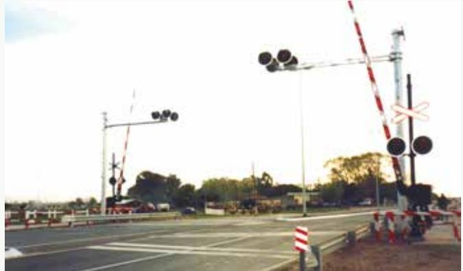
Por la altura y la calidad de las ópticas luminosas provistas, se obtiene un altísimo grado de visibilidad en la advertencia a los vehículos, cuando está pasando un tren y las barreras están bajas.
