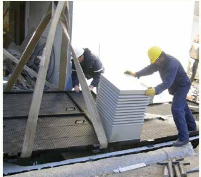
Autotrol produce en su planta cámaras de hormigón premoldeado para montaje subterráneo en tres tamaños: el modelo C1 para albergar sólo maniobras de MT, el modelo C2 para colocar sólo transformadores, y el modelo C3 que permite colocar todo el equipamiento que demanda una SET de hasta 1000KVA.
