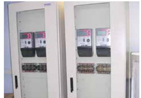
El Sistema de Medición Comercial (SMEC) de AUTOTROL responde a los requerimientos de CAMESA en lo que respecta a este tipo de sistemas, el mismo estará conformado por un gabinete metálico donde se alojarán los correspondientes equipos de medición homologados por CAMESA, incluyendo las borneras de contraste y de repetición, similar a los utilizados en las generadoras del proyecto Energía Distribuida I.
