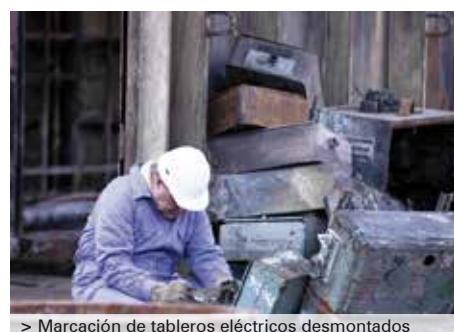
> Marcación de tableros eléctricos desmontados
