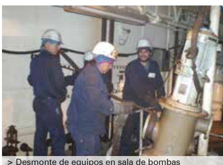
> Desmonte de equipos en sala de bombas
