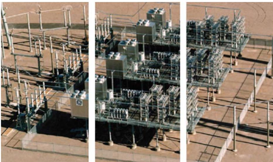
La incorporación del Sistema de Compensación de Capacitores Serie y demás equipamiento en la ET Puerto Madryn, debe realizarse necesariamente con el sistema eléctrico en operación y agregando lo necesario para que quede en condiciones de trabajo de acuerdo a las pautas elaboradas por la transportista, minimizando los tiempos de indisponibilidad del SIP.
