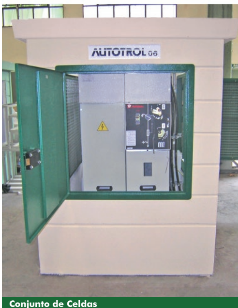
Conjunto de Celdas
