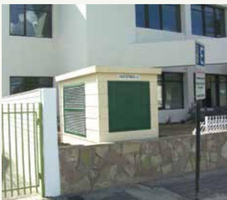
En la localidad de Río Gallegos, en las nuevas oficinas locales de OSDE, Autotrol ha instalado en el pasado diciembre, el centro prefabricado compacto más pequeño del mercado. Se trata del nuevo Chango MTB, el cual resuelve en una superficie de 1,50m x 2,50m el emplazamiento de una SET integral.
